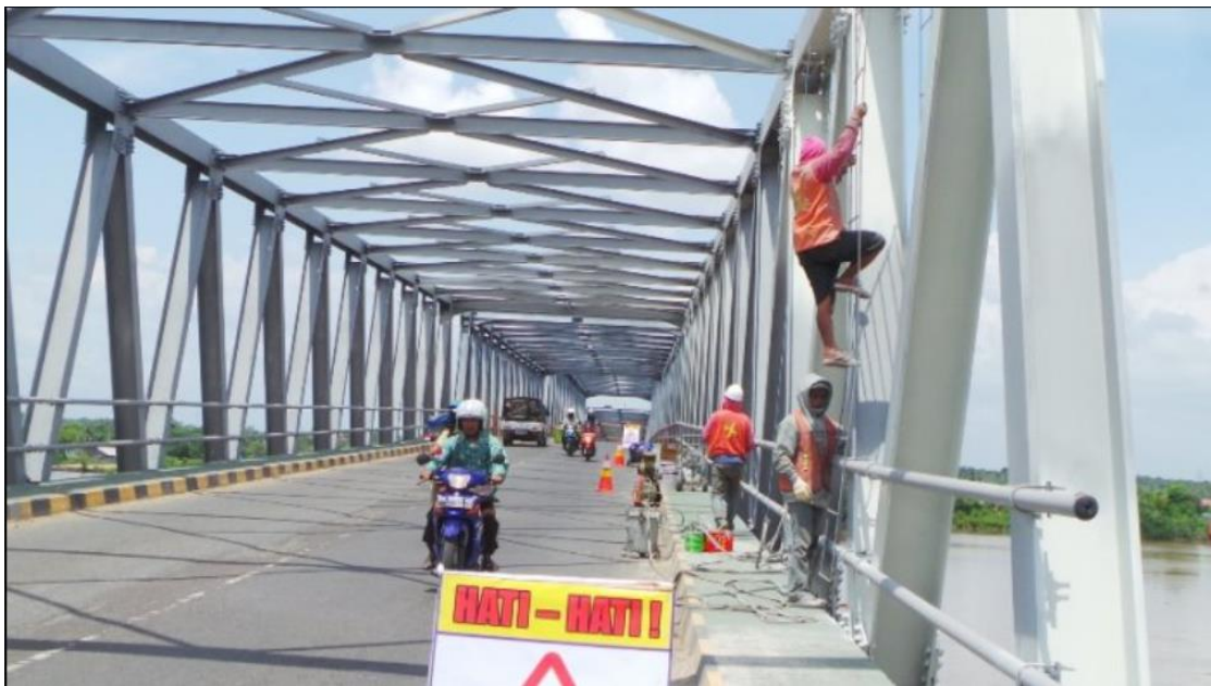
Gambar 4. Suasana pengecatan Jembatan
